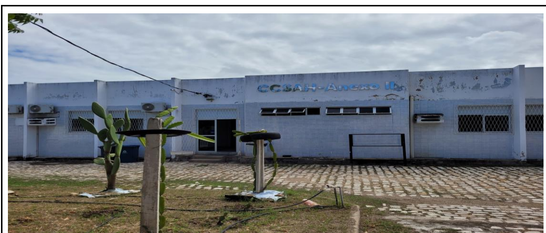
Figura 1: Fachada do prédio.
