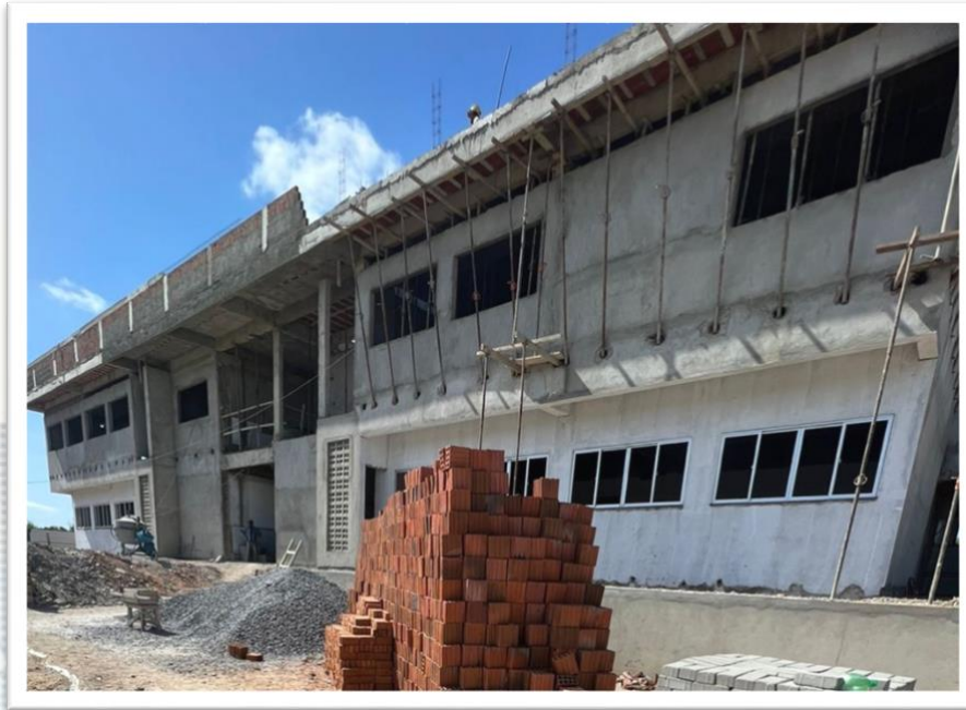
Registro da visita ao Prédio das Práticas em Administração, Ciências Contábeis e Direito (NOVEMBRO/2022)
