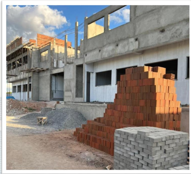
Registro da visita ao Prédio das Práticas em Administração, Ciências Contábeis e Direito (SETEMBRO/2022)
