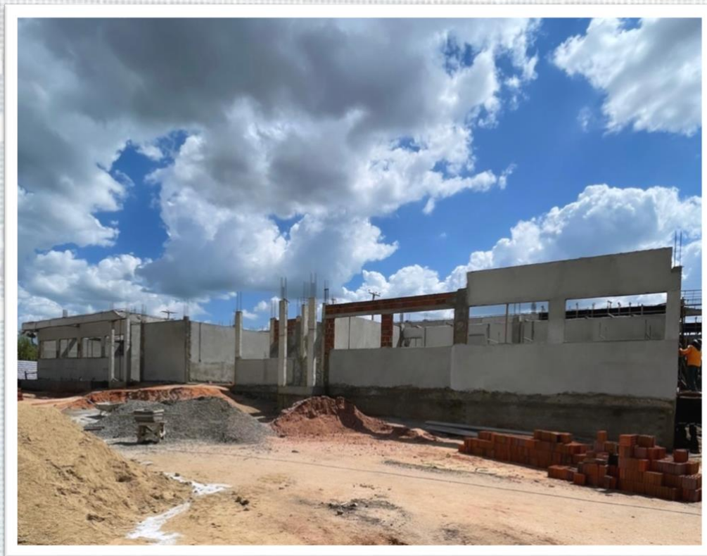
Registro da visita ao Prédio das Práticas em Administração, Ciências Contábeis e Direito (JANEIRO/2022)
