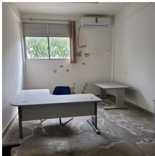
Figuras 8, 9, 10 e 11: Infiltração e mofo nas paredes das salas dos professores.
